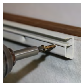
Montering av upphängningslist.
