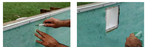
Montering av bräddavlopp
