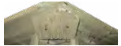
Montering av undre skarvplatta
