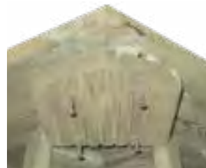
Montering av undre skarvplatta
