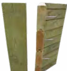
Montera förstärkningen med en skruv i varje regel.
