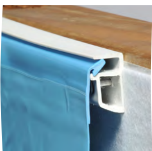
Sidobild på hur linern fästs i upphängningslisten
