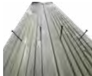
Montering av sargbrädor
