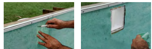
Montering av bräddavlopp
