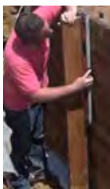
Kontrollera att förstärkningarna är vertikala.
