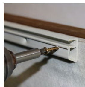
Montering av upphngningslist.
